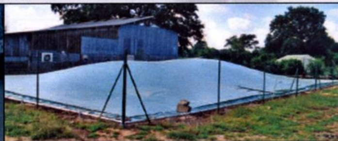
COUVERTURE DE BASSIN
